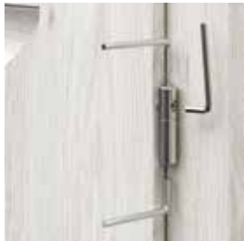
az állítható 3D pántok beállítása
