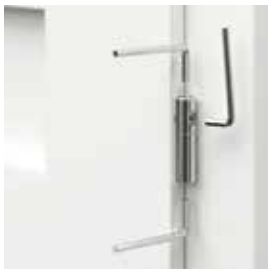
az állítható 3D pántok beállítása
