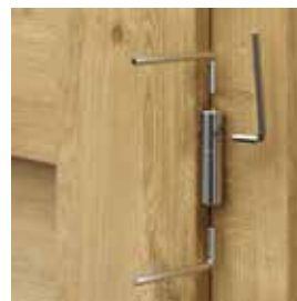
az állítható 3D pántok beállítása
