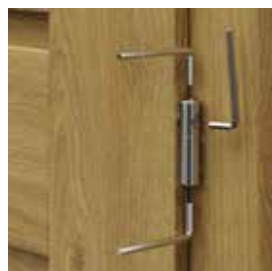
az állítható 3D pántok beállítását
